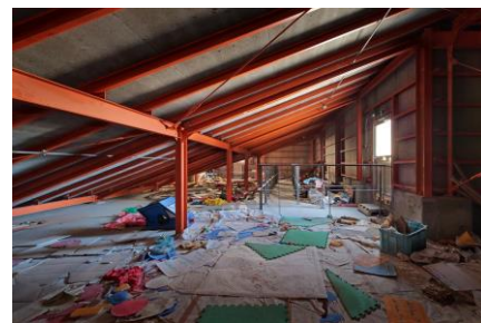
屋上倉庫内部
